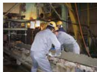
コンクリート投入
